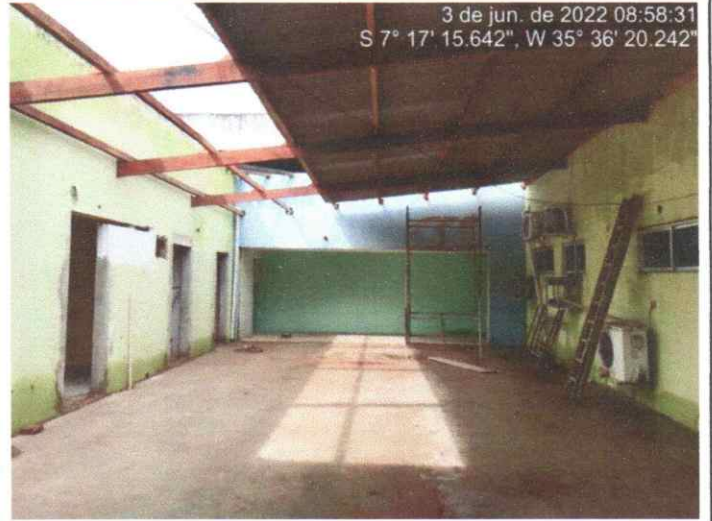
Situação atual da obra
