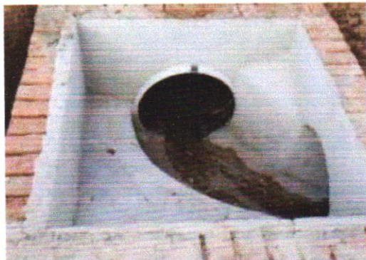
Figura 1 e 2 – Fundo das caixas de inspeção
