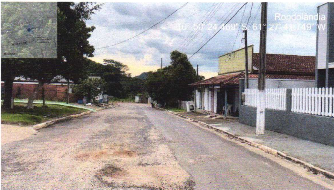
IMAGEM 45 - RUA SURUI ENTRE AV DOM BOSCO / RUA JAIME FREIRE
