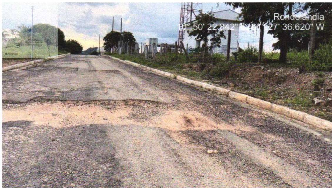
IMAGEM 41 - RUA SURUI ENTRE AV DOM BOSCO / RUA JAIME FREIRE
