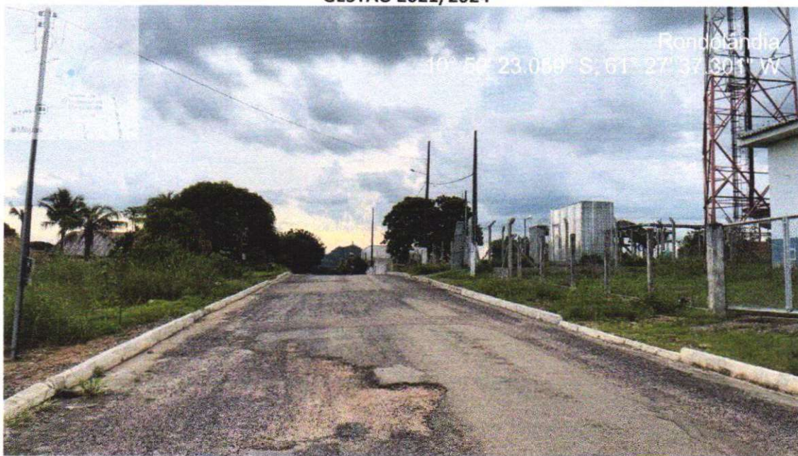
IMAGEM 42 - RUA SURUI ENTRE AV DOM BOSCO / RUA JAIME FREIRE
