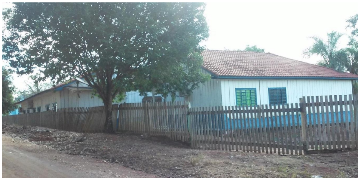
Imagem 01: Fachada da edificação
