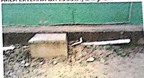
ÁREA EXTERNA/CAIXA DE INSPEÇÃO
