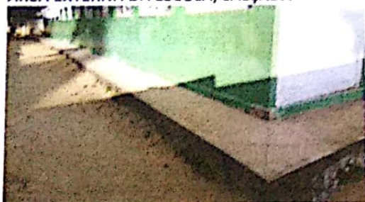
ÁREA EXTERNA DA ESCOLA/CALÇADA
