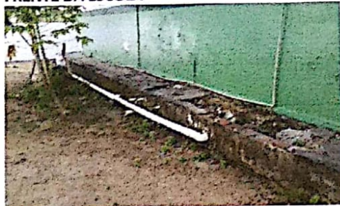
ÁREA EXTERNA DA ESCOLA/CALÇADA
