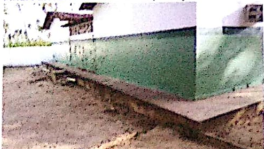
ÁREA EXTERNA DA ESCOLA/CALÇADA
