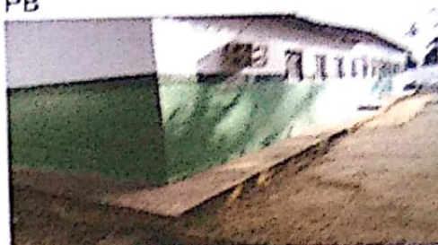
ÁREA EXTERNA DA ESCOLA/CALÇADA
