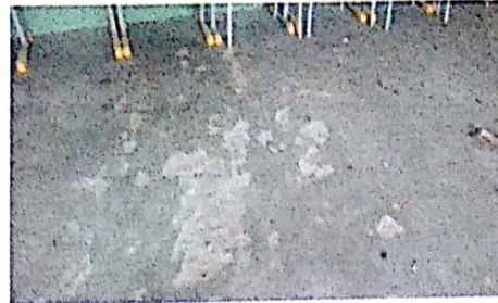
PISO DE SALA DE AULA
