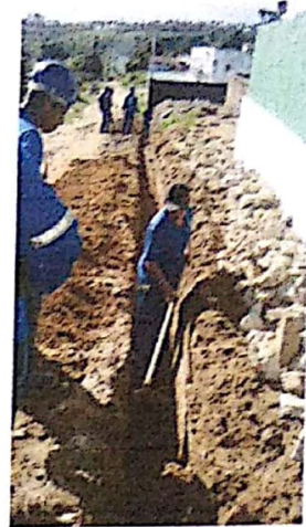
FRENTE DA ESCOLA/MURO
