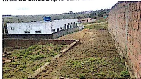
ÁREA EXTERNA/SEM MURO
