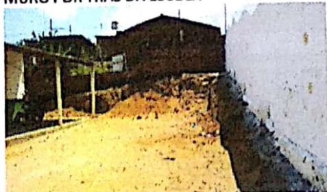
MURO POR TRÁS DA ESCOLA
