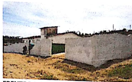
FRENTE DA ESCOLA/MURO
