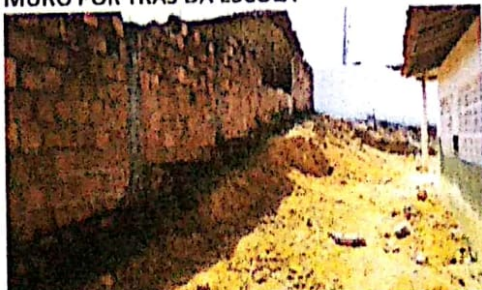
MURO POR TRÁS DA ESCOLA
