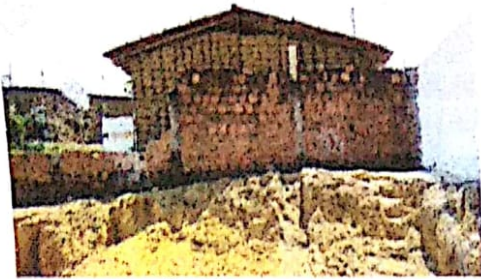
MURO POR TRÁS DA ESCOLA
