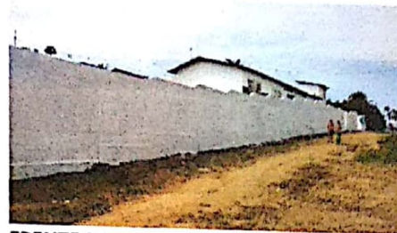
FRENTE DA ESCOLA/MURO
