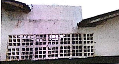
COMPLEMENTO DE ALVENARIA
