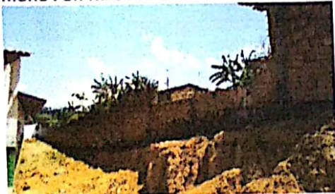
MURO POR TRÁS DA ESCOLA
