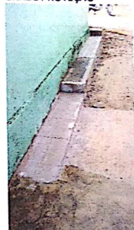
RECUPERAÇÃO DE CALÇADA
