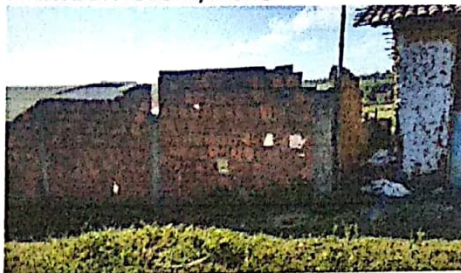
FRENTE DA ESCOLA/MURO
