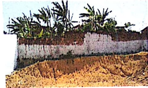
MURO POR TRÁS DA ESCOLA
