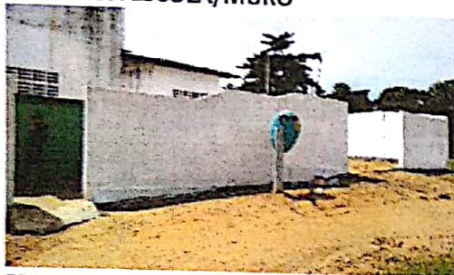
FRENTE DA ESCOLA/MURO
