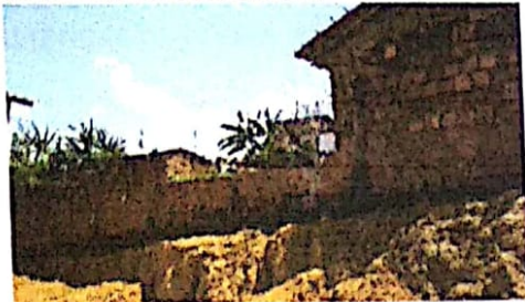
MURO POR TRÁS DA ESCOLA
