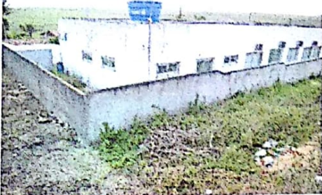
ÁREA EXTERNA/SEM MURO
