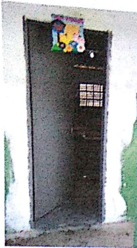
PORTA DE SALA DE AULA
