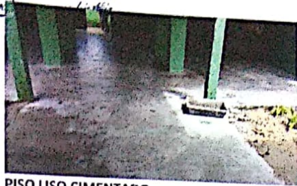
PISO LISO CIMENTADO
