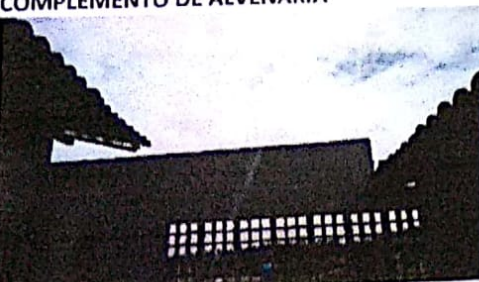
COMPLEMENTO DE ALVENARIA
