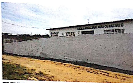
FRENTE DA ESCOLA/MURO
