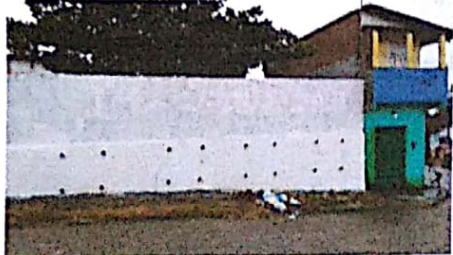
FRENTE DA ESCOLA/MURO
