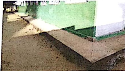
ÁREA EXTERNA DA ESCOLA/CALÇADA
