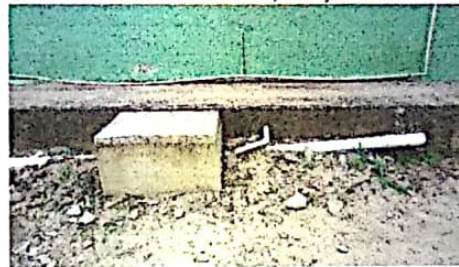
ÁREA EXTERNA/CAIXA DE INSPEÇÃO
