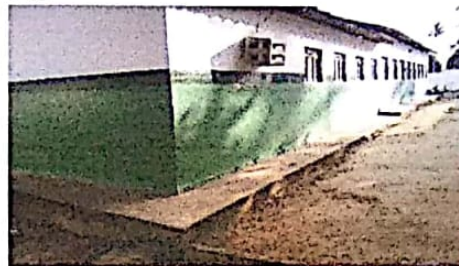
ÁREA EXTERNA DA ESCOLA/CALÇADA
