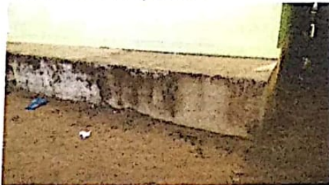
ÁREA EXTERNA DA ESCOLA/CALÇADA
